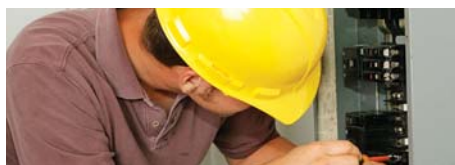
ÁREAS DE MANTENIMIENTO
